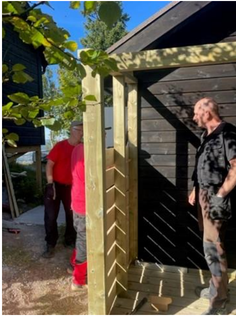
Oppsetting av vedbod ved Peilehytta
